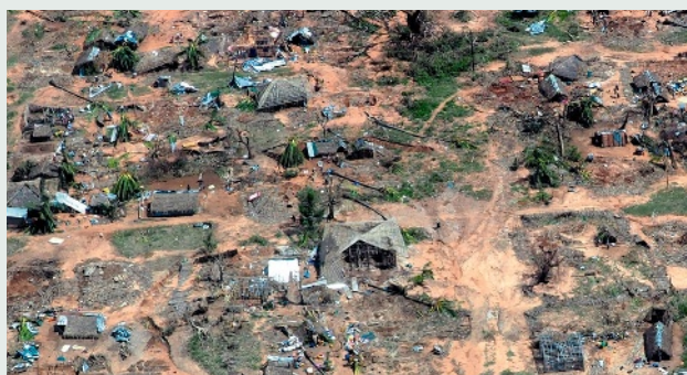
L'eau et le vent d'un cyclone occasionnent de très nombreux dégâts, à l'image de ceux observés à la Nouvelle-Orléans, aux États-Unis, après le passage de Katrina en 2005 (en haut), et dans la région de Beira, au Mozambique, touchée par le cyclone Idai, en 2019 (en bas).
